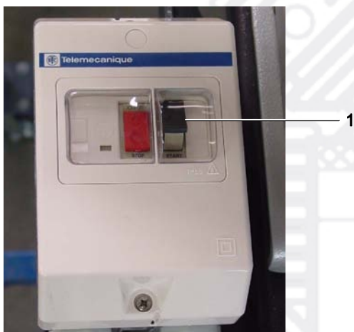
Рис. 22 Предохранительный выключатель двигателя, Mariner
