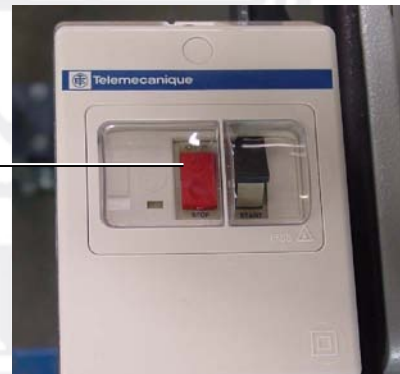
Рис. 30 Предохранительный выключатель двигателя, Mariner
